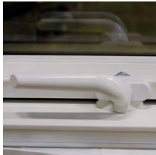
Manecilla lacada en color blanco, situada en el travesaño inferior de la hoja, provista de 1 punto de aireación (posición entreabierta).
