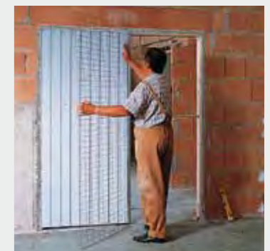
6. Después de rejuntar el armazón y el tabique con cemento, colocar la red metálica.
