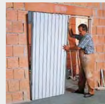
4. Colocar el armazón, nivelar y fijar a la pared con puntos de cemento o yeso.
